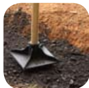
2. Add and Compact Pave Base 2. Agregar y com- pactar la grava.
